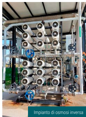
Pieve Vergonte - impianto trattamento acque di falda tra i più grandi d'Europa (1.200 Mc/h)
