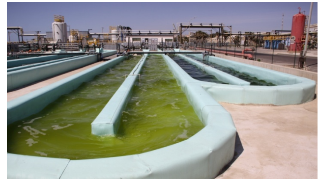
Vista dell'impianto pilota da un ettaro in esercizio a Gela
