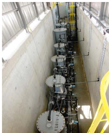
PRB pilota di Taranto: vista del sistema reattivo contenente le zeoliti ed il materiale per l'assorbimento di As
